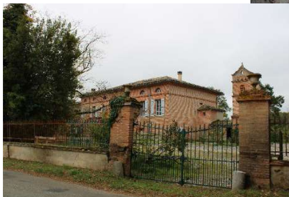
Figure 49 : Panorama de batisses anciennes, sources : Photographie novembre 2021 et Google Street View
