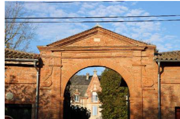
Figure 41 : Foyer de vie Les Marronniers, photographie novembre 2021 Paysages
