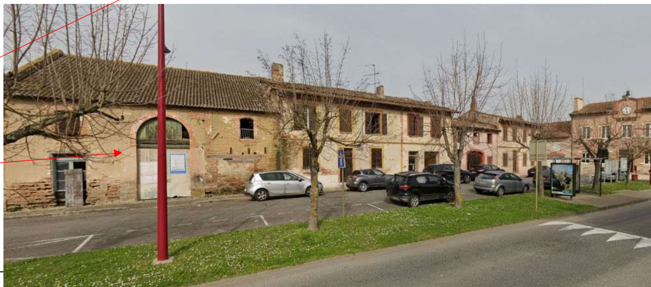
Figure 63 : Densification et rénovation dans le cœur de bourg, source : Google Street View et Géoportail
