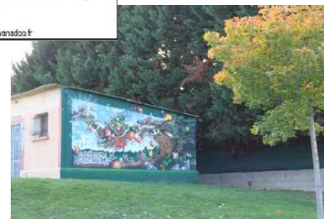
Figure 90 : Photographies de la Maison des Associations, photographie Novembre 2021,
